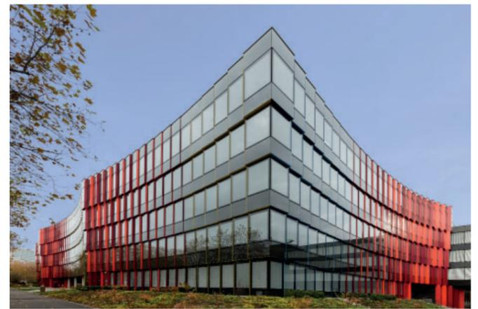
Die neu gestaltete Fassade überrascht den Betrachter je nach Blickwinkel mit Farbwechseln in Rot, Grün, Blau und Gelb. Ein im Grundriss geschwungener Fassadenverlauf unterstützt diese Wirkung.
